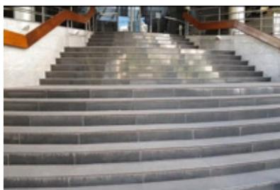
*Ao lado, fotos de “antes” e “depois” das obras com fins de promoção e acessibilidade no edifício sede do TRE/ES, com instalação de plataformas de elevação para cadeirantes, substituição dos corrimãos da escadaria frontal, bem como marcação com piso tátil na referida escadaria e rampas adjacentes.*
